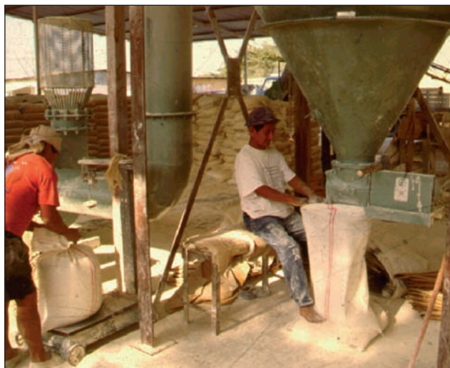
Foto 5. Operación de molienda y ensacado de cal en Ecuador.
